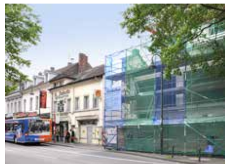
Noch eine Baustelle: Opladen, Kölner Str. 58.
